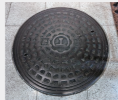
営団設立時のマークが入った マンホールの鉄蓋(当館展示) 丸ノ内線建設に伴い、サンシャイン60 通りの歩道上に設置されていたもの
