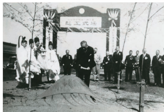
丸ノ内線起工式 1951(昭和26)年
